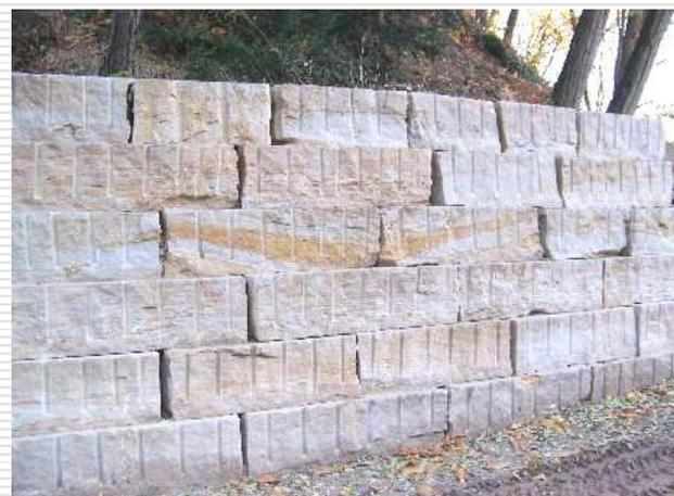
**Blockmauerwerk, Lagerfugen gesägt, Sichtseite gespalten mit Bohrlochspuren, Rückseite gesägt/gespalten, Steinlänge 60-140 cm, Querschnitt 30/30 oder 40/40 cm.**
